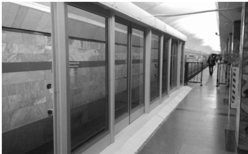
Рис. 1. Апробирование станционных автоматических дверей для станций открытого типа.
